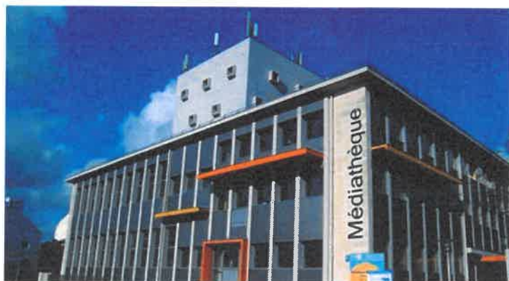
LA MÉDIATHÈQUE DE SAINT-NAZAIRE. - PHOTO PHOTOS VILLE DE SAINT-NAZAIRE
